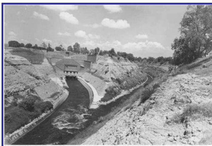
Imagen 4.4.15: Parte final del Gran Canal donde se divide en dos, el canal de la izquierda llega al Túnel Nuevo de Tequixquiac y el derecho al viejo Tequixquiac, Estado de México 1965; Fuente: Archivo Histórico del Agua, México 2010.
