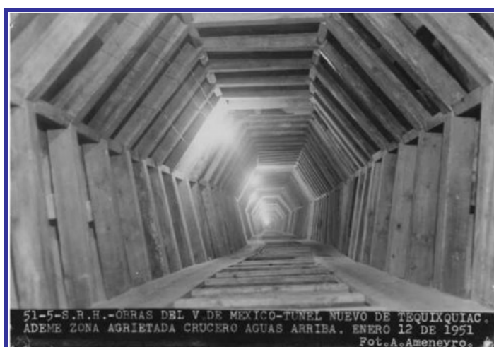
Imagen 4.4.14: Ademe colocado en la zona agrietada del Nuevo Túnel de Tequixquiac, Estado de México 1951; Fuente: Archivo Histórico del Agua, México 2010.
