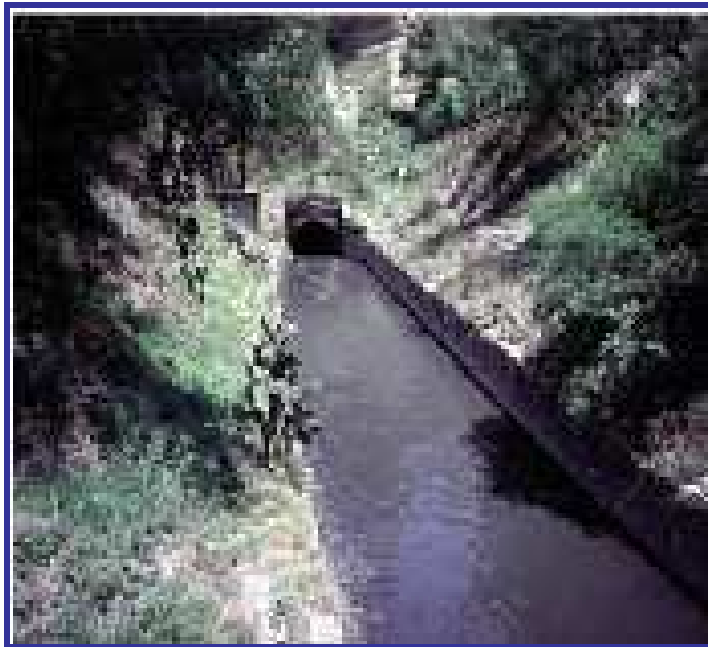
Imagen 4.4.12: Túnel de Tequixquiac, Estado de México, 1886 – 1900; Fuente: Archivo Histórico del Agua, México 2010
