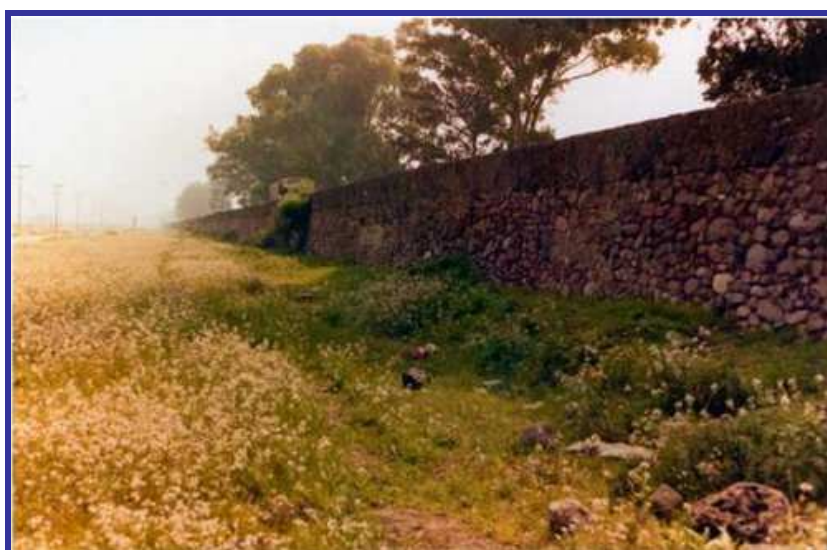
Imagen 4.4.4: Muro del Albarradón de Ecatepec, aún en buen estado; su función era evitar los derrames de los lagos de San Cristóbal, Xaltocan y Zumpango sobre el de Texcoco. Fuente: Archivo Histórico del Agua, México 2010.
