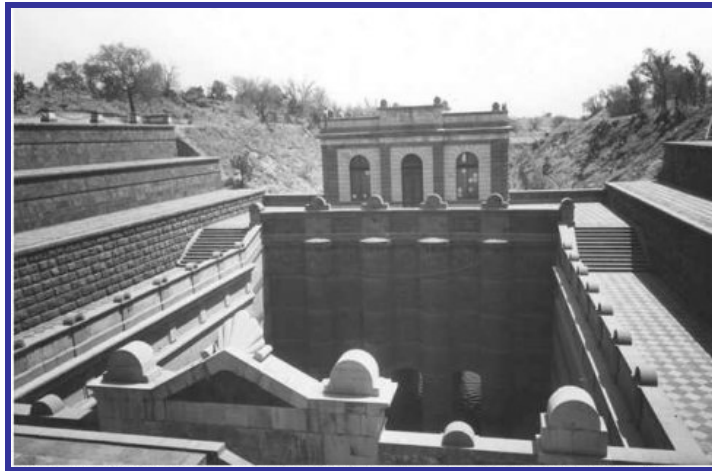
Imagen 4.4.11: Caja Colectora del Túnel de Tequixquiac, se observa el cuarto de maquinas y las compuertas, 1973; Fuente: Archivo Histórico del Agua, México 2010
