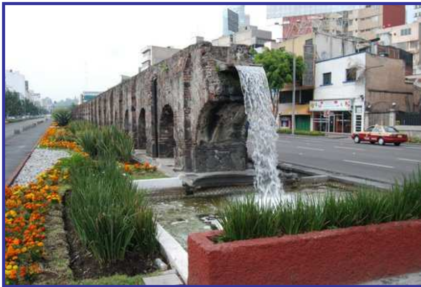
Imagen 4.4.5: Acueducto del Arco de Belén, Chapultepec, Ciudad de México, 1620 – 1790; Fuente: Archivo Histórico del Agua, México 2010.
