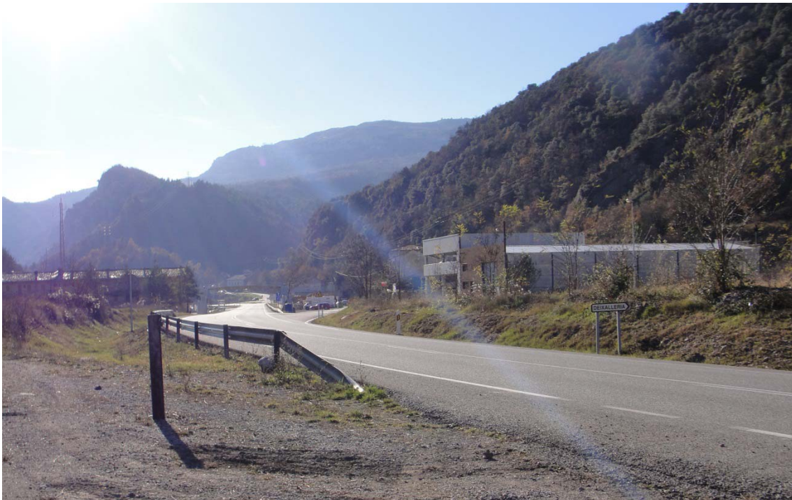
Figura 47: Alt Berguedà. Solape sendero con carretera de la red básica Fuente: Elaboración propia
