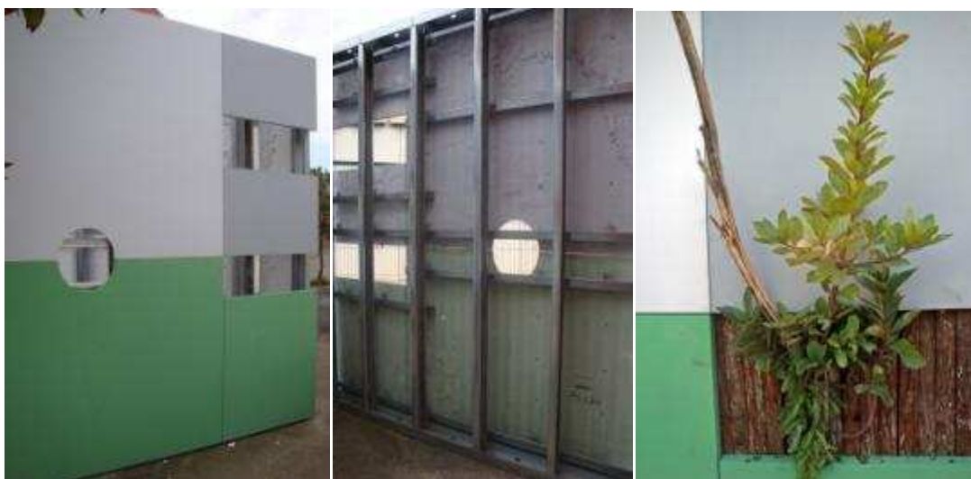
Fig. 37 Solució de façana ventilada per aplacar sobre façana existent amb la incorporació d'elements vegetals (en aquest cas garrofers) com a filtre solar i element ornamental. Gentilesa de Max Volckaert.
