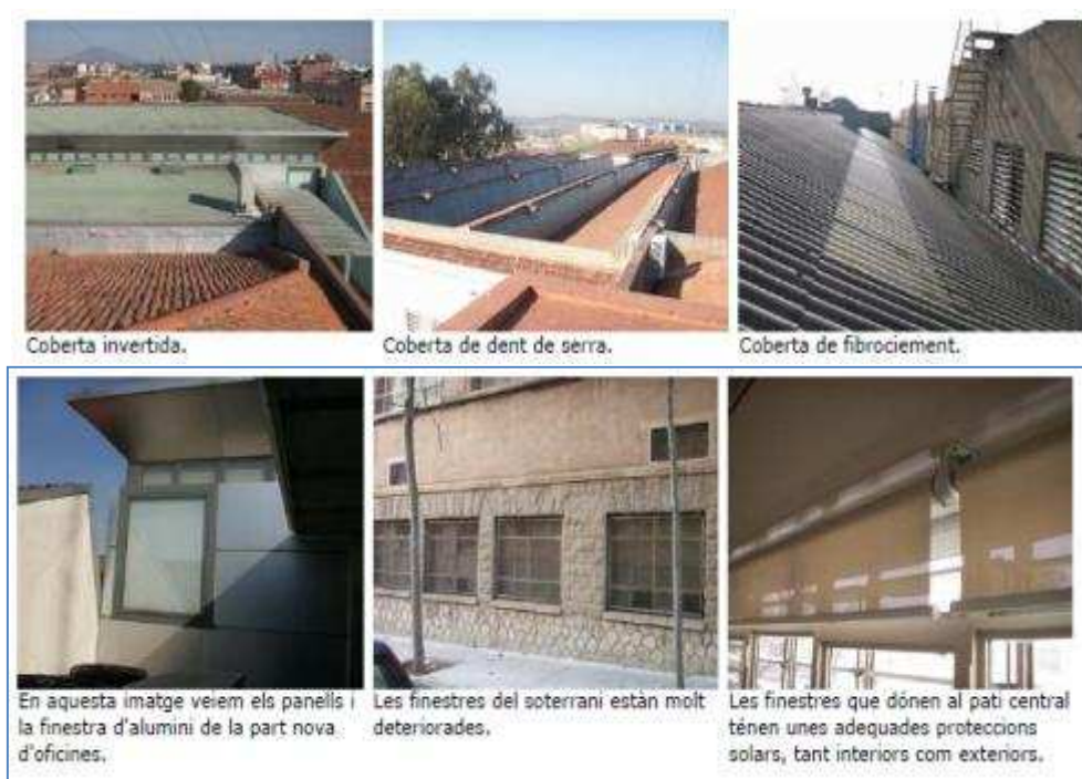
Fig. 32 Diferents solucions de cobertes i façanes en edificis escolars de Barcelona i Sabadell. Font pròpia
