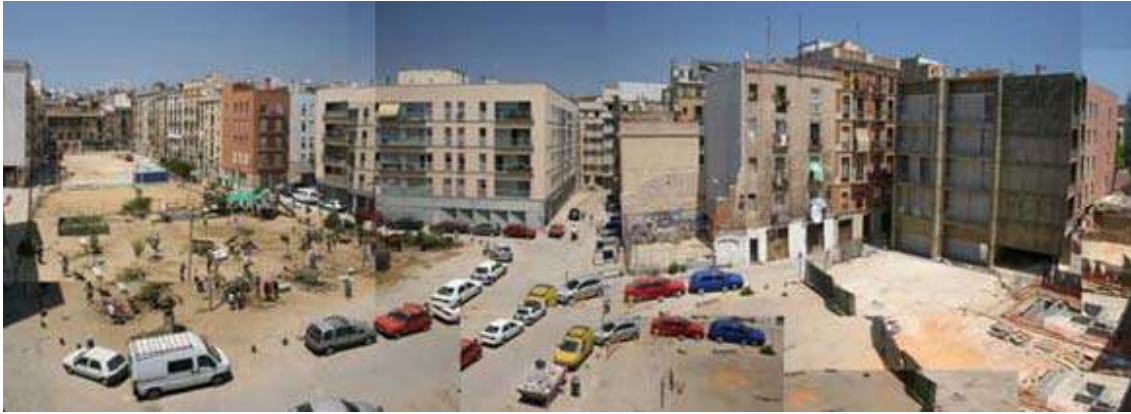
Figura 12: Imatge del solar de 5000 m 2 resultat de l'enderrocament previst pel PERI Font: Josep M o Solé Gras
