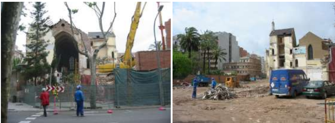
Figura 46: Enderroc del convent de les Germanetes dels Pobres
