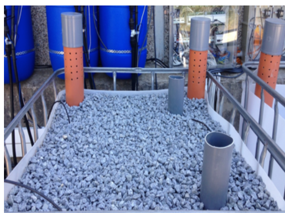
Fotografía 20. Vista del humedal con medio filtrante de corcho y los depósitos de entrada al fondo. Fuente: L. Aguilar.
