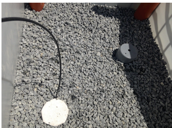
Fotografía 17. Sobre el geotextil se coloca el medio filtrante de 16 mm y los muestreadores. Fuente: L. Aguilar.
