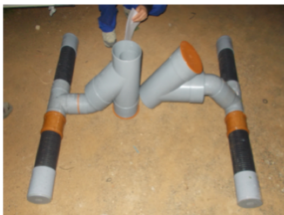
Fotografía 42 y 43. Tuberías de recolección de agua y sensores de nivel en los humedales horizontales. Fuente: A. Gallegos.
