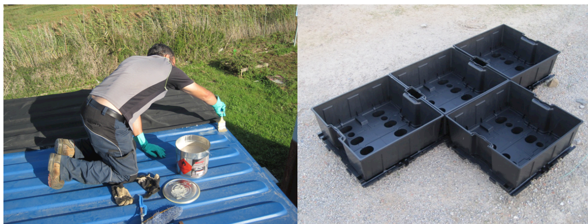
Fotografía 50 y 51. Trabajos de impermeabilización de la cubierta y sistema modular Igniagreen. Fuente: A. Gallegos.
