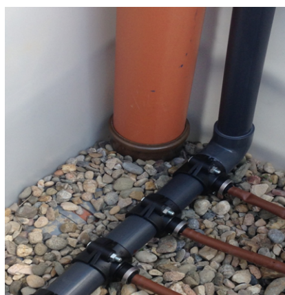
Fotografía 22. Vista del detalle del montaje del sistema de distribución de aire. Fuente: L. Aguilar.
