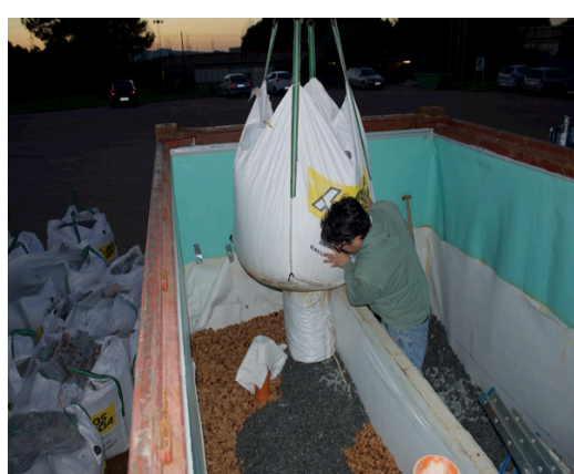
Fotografía 44 y 45. Las diferencias entre el medio granular de los humedales horizontales permitirán comparar la eficiencia de remoción del sistema entre el sustrato tradicional como grava y un subproducto de otras actividades como el corcho. Fuente: J. Morató.
