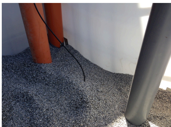
Fotografía 25. Vista del humedal con medio filtrante de grava. Fuente: L. Aguilar.
