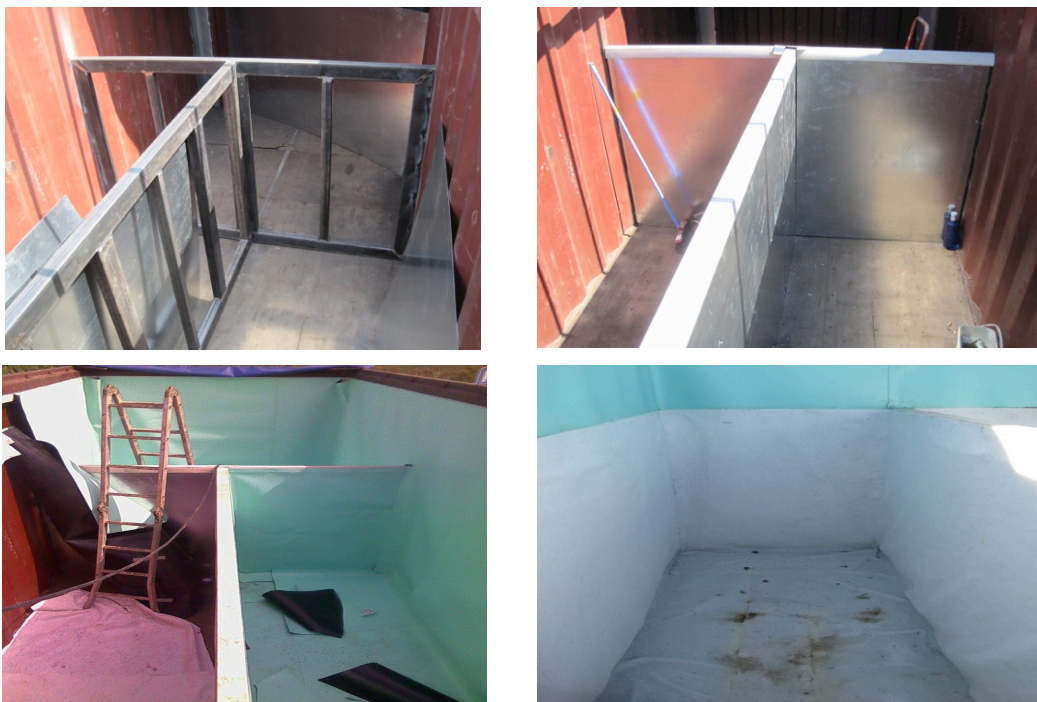
Fotografía 36, 37, 38 y 39. Estructura metálica dentro del contenedor OpenTop y geomembrana y geotextil de impermeabilización. Fuente: L. Aguilar.
