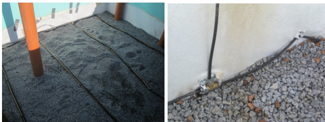
Fotografía 46 y 47. Una adecuada distribución del agua en la superficie de los humedales permite que tengan el rendimiento de tratamiento esperado. Fuente: L. Aguilar.
