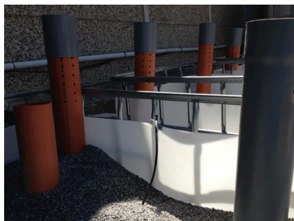
Fotografía 18. Se coloca el medio filtrante de gravilla de 5 mm. Fuente: L. Aguilar
