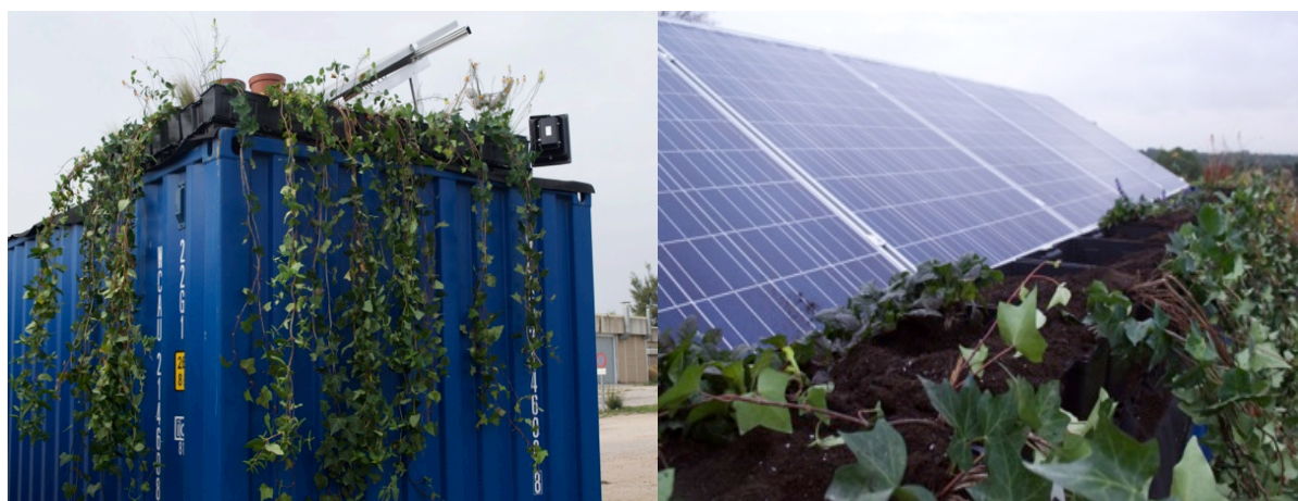
Fotografía 48 y 49. Vista del muro vegetal y la cubierta. Fuente: J. Morató.
