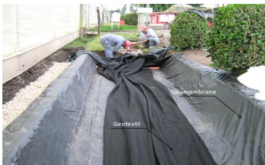
Fotografía 3. Instalación de polietileno de alta densidad y geotextil para la impermeabilización del sistema. Heraclio Bermudez ©.
