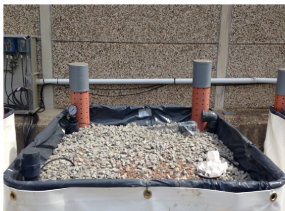
Fotografía 24. Se coloca el medio filtrante de gravilla de 5 mm. Fuente: L. Aguilar
