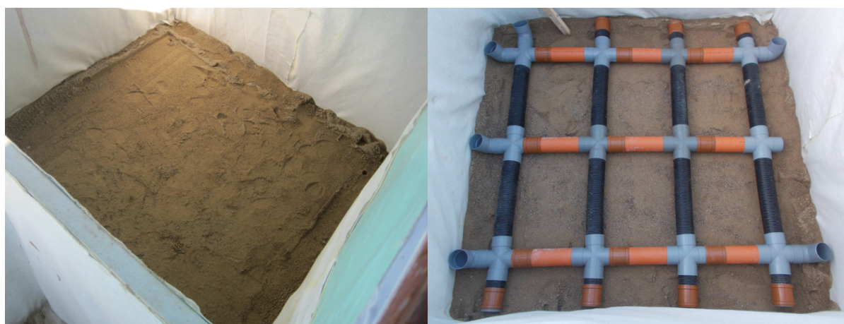
Fotografía 40 y 41. Cama de arena compactada y tubería de recogida del humedal vertical. Fuente: L. Aguilar.
