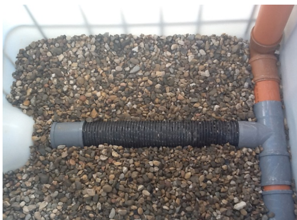
Fotografía 15. La capa de drenaje con grava de 16 mm va en el fondo del humedal, después de haber colocado la tubería de drenaje. Fuente: L. Aguilar
