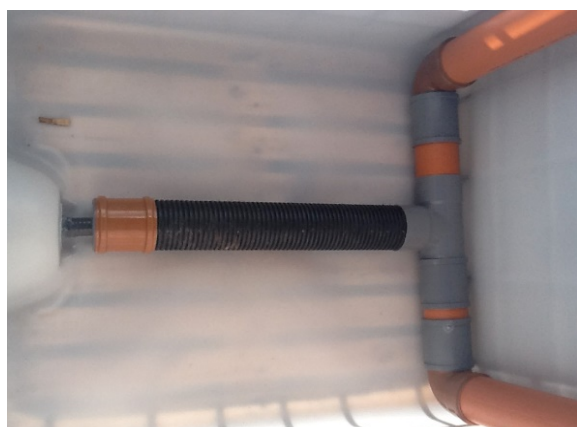
Fotografía 13. Una vez cortada la tapa superior de los depósitos de los humedales se instala en el fondo la tubería de drenaje y de aireación. Fuente: L. Aguilar.
