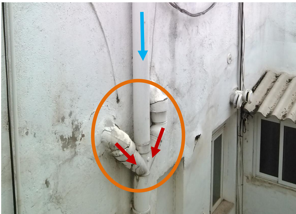
En aquesta imatge podem apreciar com s'incorporen les aigües grises i negres al baixant de pluvials (zona indicada en taronja).
