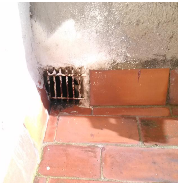
Desguàs comú de pluvials d'un terrat.
