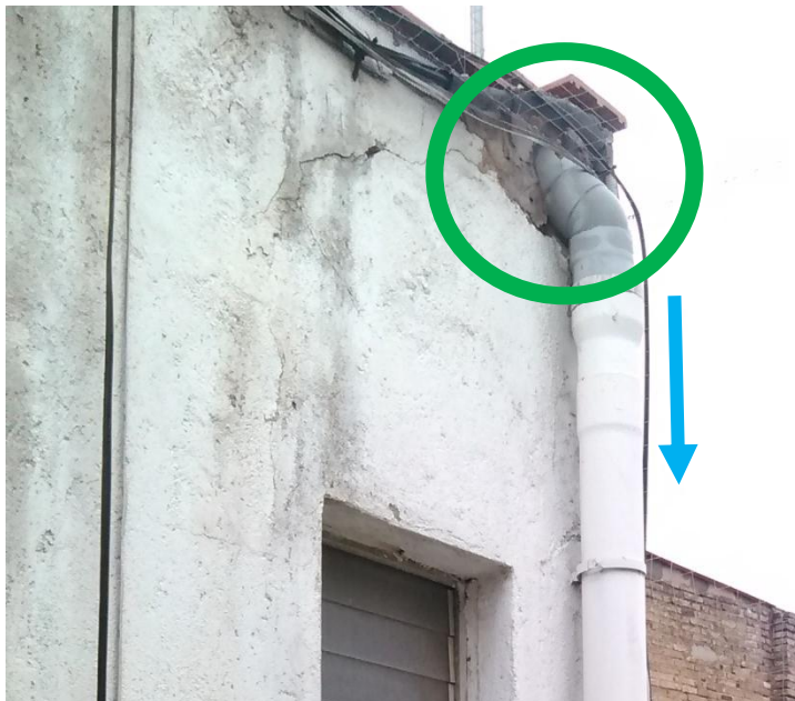
Envoltat per un cercle verd: Detall d'un baixant en el punt on es produeix l'entrada d'aigua de la superfície de la teulada.
