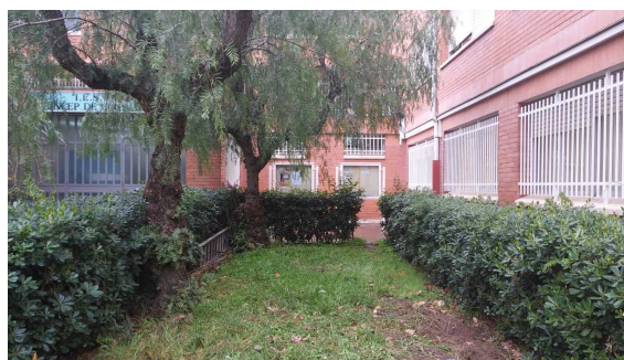
Vista Nord-oest de la parcel·la amb l'accés al fons.
